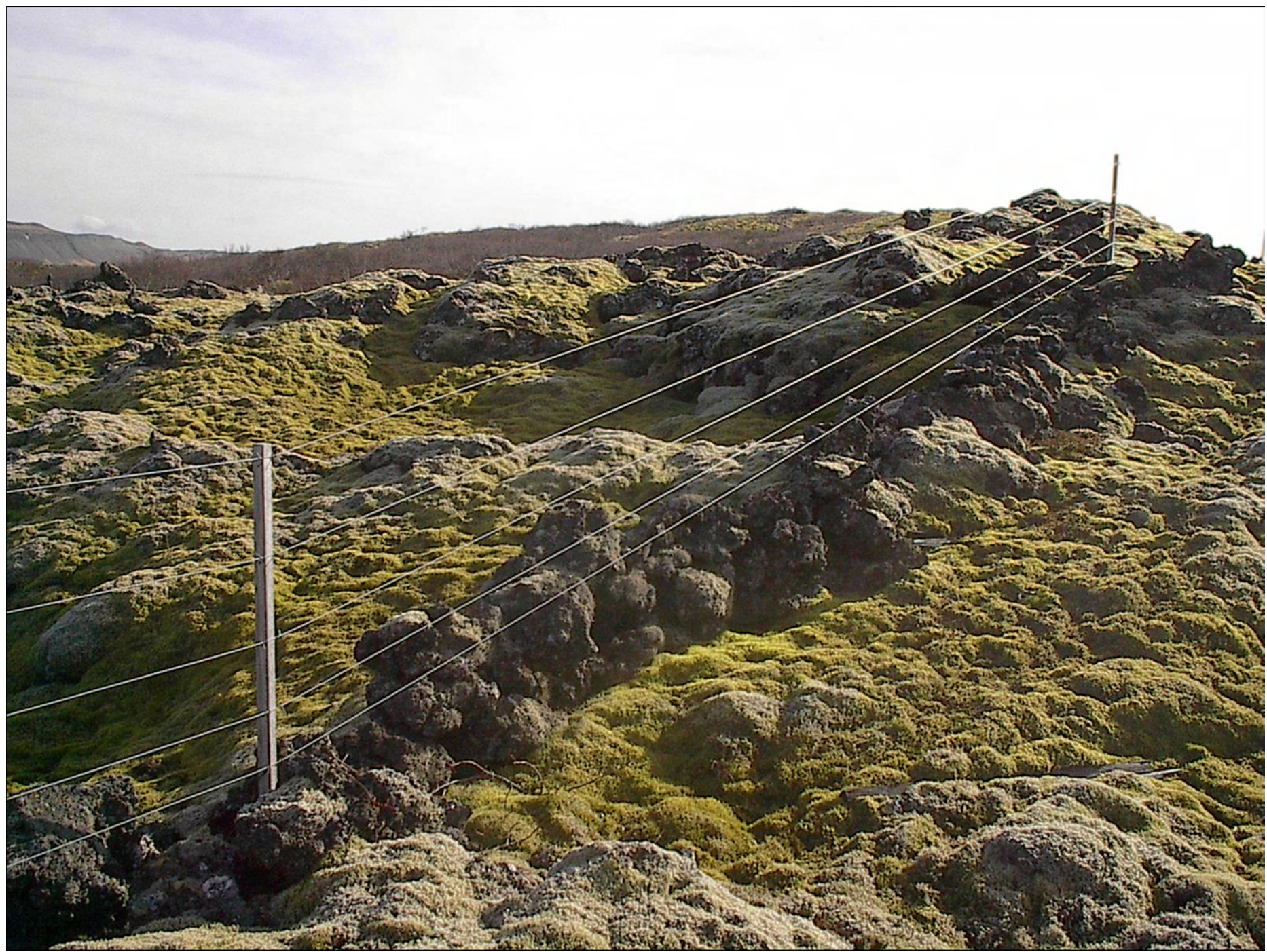
Undirgirðingar og undirhleðslur eiga að vera ótengdar aðalgirðingu. Hleðsla úr hraungrýti.
